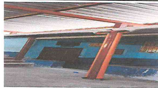
CANALES DE PVC Y CAIDAS DE AGUA TERMINADA
