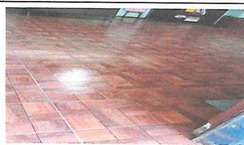
PISO CERÁMICO TERMINADO
