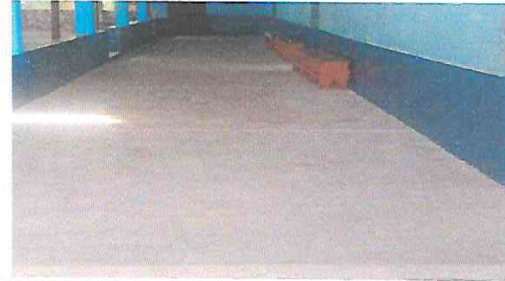
PISO DE CEMENTO TERMINADO
