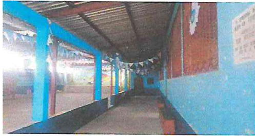
SELLADO DE GRIETAS Y FISURAS, FINALIZADO.
