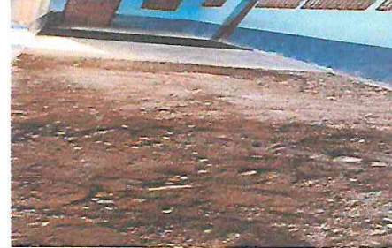
REPARANDO PISO DE CEMENTO
