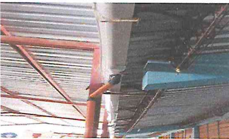
SUSTITUYENDO CANAL DE PVC
