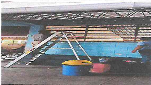
PINTURA DE MUROS EXTERIORES E INTERIORES
