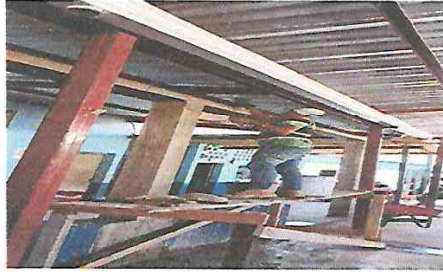
TRABAJANDO SELLADO DE GRIETAS Y FISURAS
