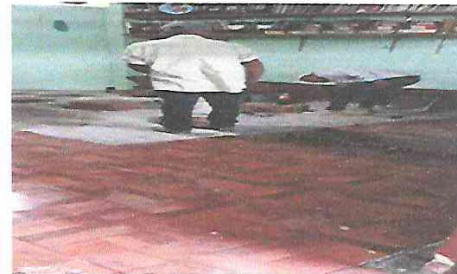
SUSTITUCIÓN DE PISO
