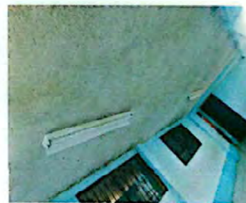
Foto 6: sustitución de focos ahorradores
