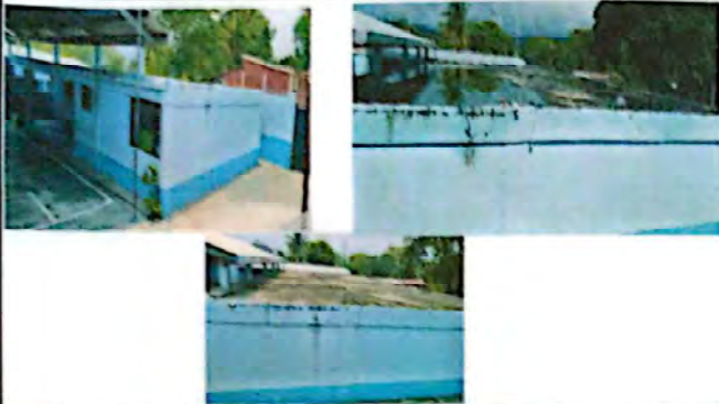
Foto1: Impermeabilización de losa
