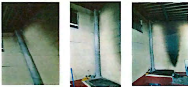
Foto 3: reparación de chimenea de concreto
