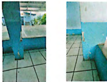
Foto 2: repello de muros
