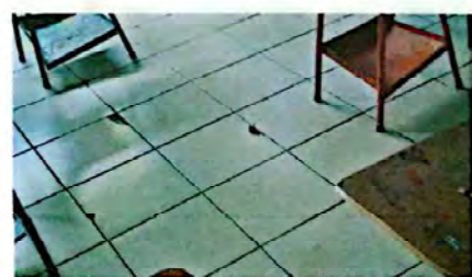
Foto 6: sustitución o instalación de piso cerámico
