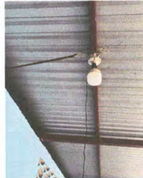
Foto 2: Reparación de sistema eléctrico
