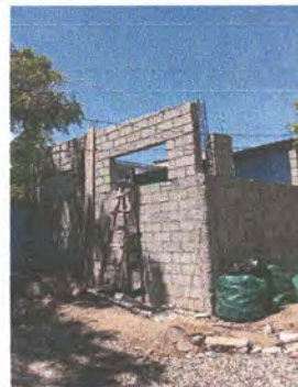
Foto 4: Colocación de techo nuevo
