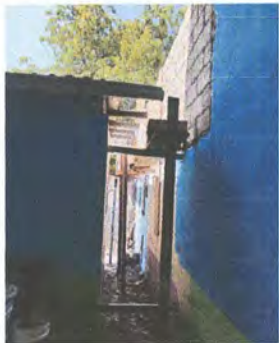
Foto 5: Parte de afuera del techo de cocina
