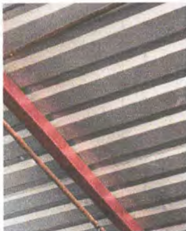
Foto 5: Reparación de sistema eléctrico
