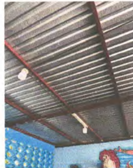
Foto 6: Reparación de sistema eléctrico
