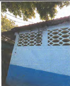
Foto 1: Reparación de sistema eléctrico
