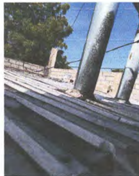
Foto 2: parte de afuera del techo de cocina
