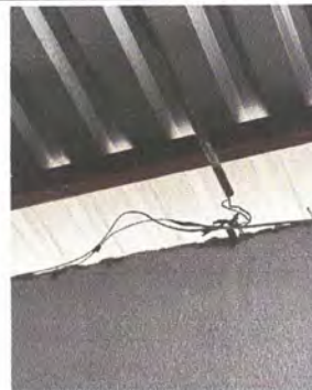
Foto 4: Reparación de sistema eléctrico
