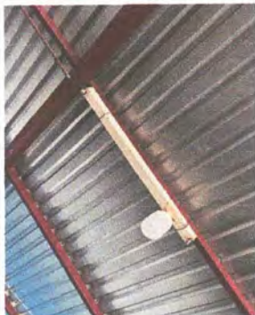
Foto 3: Reparación de sistema eléctrico
