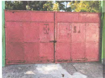
Foto 4: Mantenimiento de portón (sustruir lámina, tubo, lijado y pintura)
