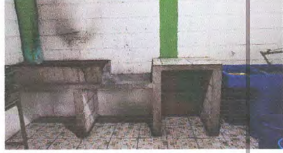
Foto 2: sustitución de mueble de concreto
