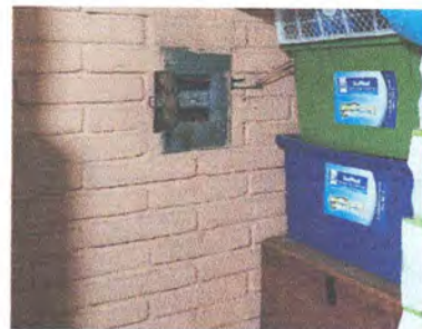
Foto 6: sustitución de caja y flipones
