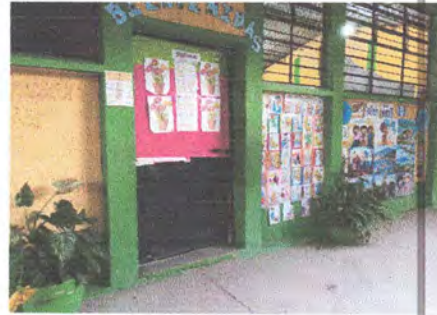
Foto 4: sustitución de puertas de metal
