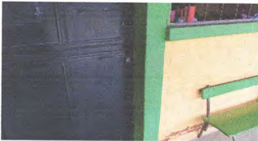
Foto 5: Sustitución de chapa en puera
