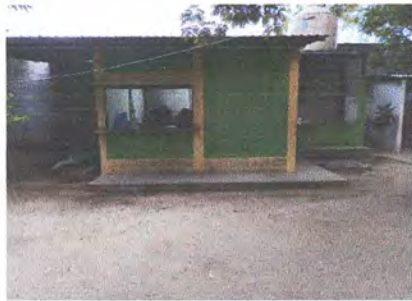
Foto 3: Sustrucción de plancha de concreto
