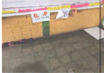
Foto 2: Sustitución de tomaferzas (Tomacorriente, cajas, cable flexitubo y tubo) en cada aula
