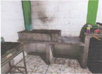
Foto 1: Sustrucción completa de estufa rural
