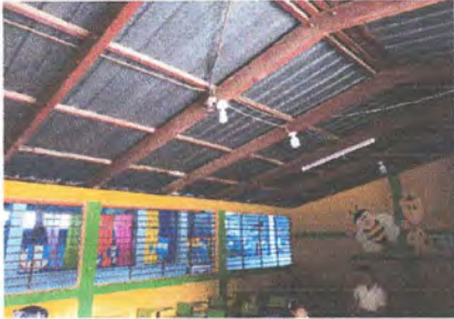
Foto1: Sustitución de luminarios (Bombillos, plafonera, cable, tubo y flexitubo) en cada alula
