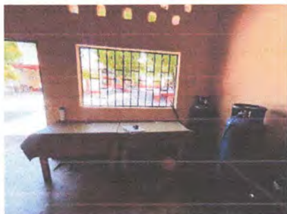
Foto 3: Mantenimiento a balcones de metal
