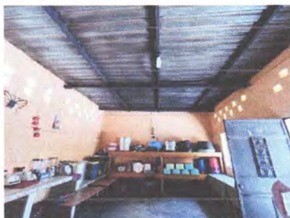
Foto7: Sustitución de focos ahorradores, plafoneras y tomacorrientes
