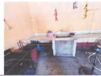
Foto 6: Sustitución de lavatrastos por pila de concreto de dos fosas con azulejo en interior y exterior
