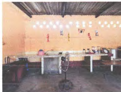
Foto 8: Pintura en muros
