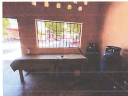
Foto 4: Fabricación e instalacion de ventanas de PVC
