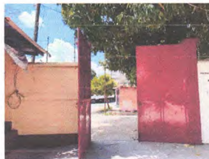
Foto 10: Instalación de estructura metálica en ingreso
