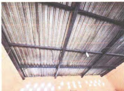
Foto1: Mantenimiento a estructura de soporte de metal (lijado y pintura)
