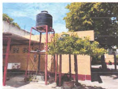
Foto 12: Sustitucion de depósito de agua de 2,500 litros
