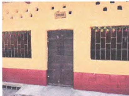
Foto 2: Mantenimiento a estructura de puerta de metal
