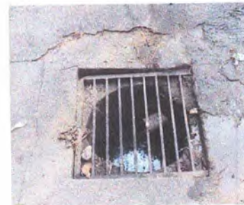
Foto 6: Mantenimiento a cajas de registros
