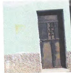
Foto 2: Mantenimiento a estructura de puertas.
