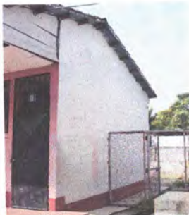
Foto 5: Pintura en muros exteriores e interiores.
