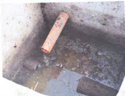
Foto 7: Sustitución de tubería PVC línea principal aguas negras
