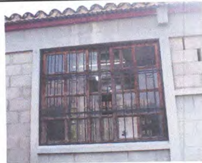
Foto 4: Sustitución de ventanas de madera por metal mas vidrio.
