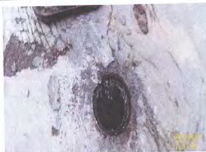
Foto 8: Sustitución de reposadera
