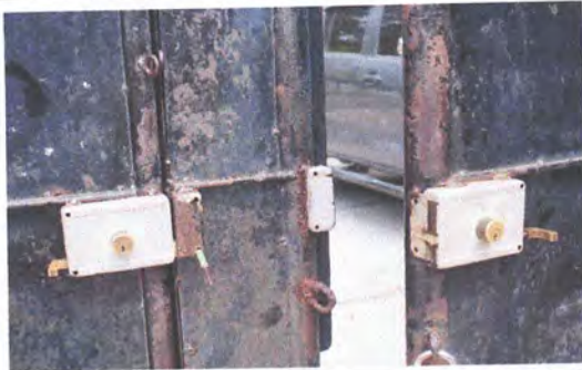
Foto 3: Sustitución de chiapas de puertas.
