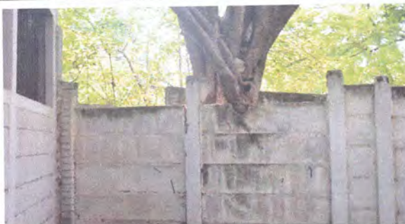
Foto 9: Reparación de muro perimetral de block
