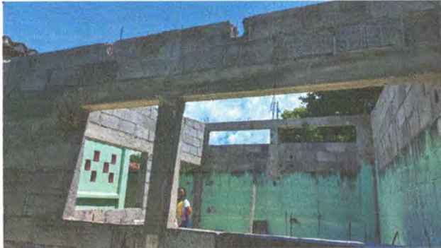
Foto1: MODULO COCINA. 1.1 Sustitucion de lamina por lamina troquelada aluzinc calibre 26 (roja y blanco)
