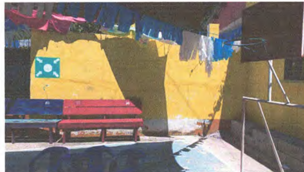
Foto 14: 13. Pintura en muros exteriores (muros)
