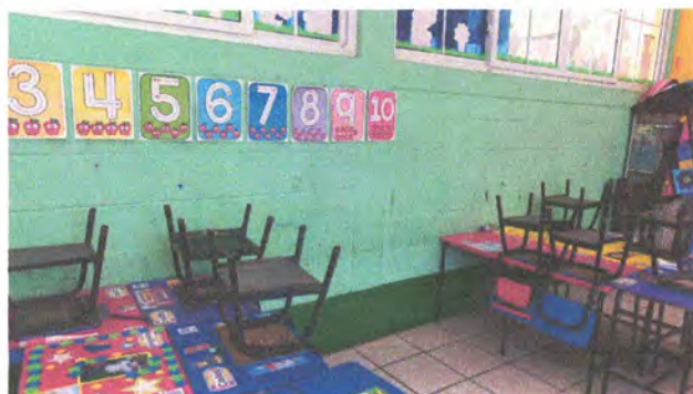
Foto 15: 13. Pintura en muros exteriores (salones de clases)
