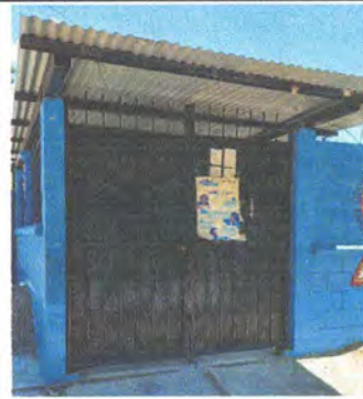
Foto 12: 9.1 Mantenimiento a portón de ingreso
