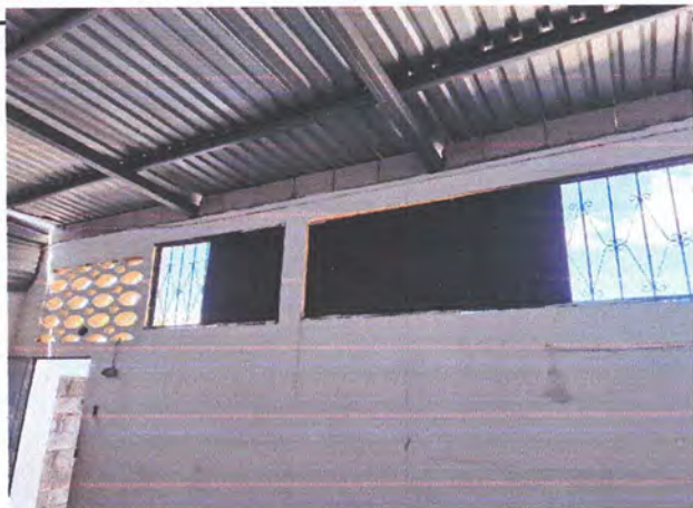
foto 3. Sustitucion e instalacion de balcones de metal
