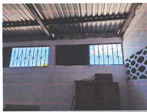
Foto 2: sustitucion de estructura de metal elevado
