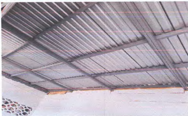
Foto:1. Instalacion de cielo falso
