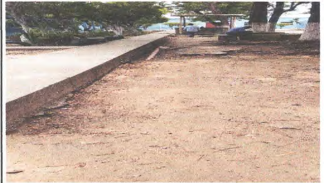
FOTO 4: SUSTITUCIÓN DE PLANCHAS DE CONCRETO.
