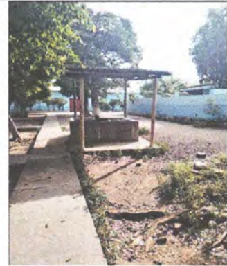
FOTO 2: SUSTITUCIÓN DE ESTRUCTURA DE SOPORTE Y LAMINA.
