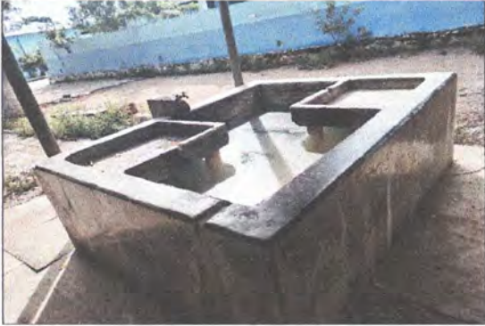
FOTO 1: SUSTITUCIÓN DE PILA DE CONCRETO.
