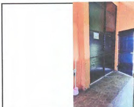
Foto 17: Mantenimiento de porton de metal de ingreso (hacia patio: cambio de picaporte, cambio de pines, soldadura, lijado y pintura)
