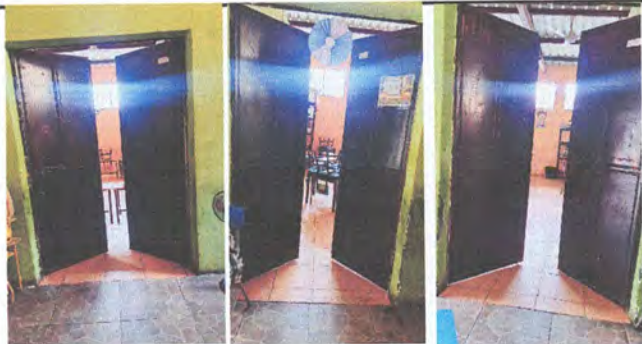
Foto 9: Mantenimiento de puertas de metal.(son doble hoja 1.20*2.10)
