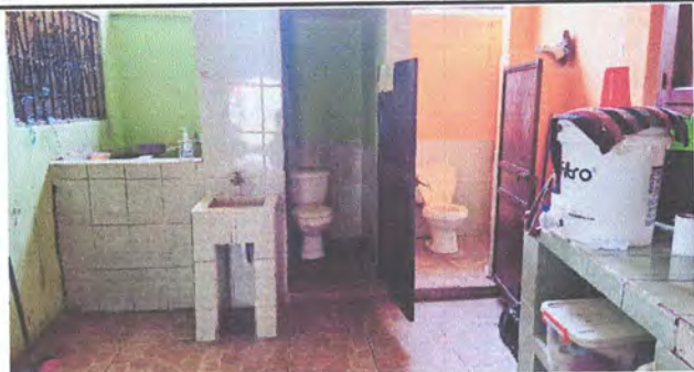
Foto 1. Suministro e instalaciones de sanitarios de una sola pieza de buena calidad (deposito push)
