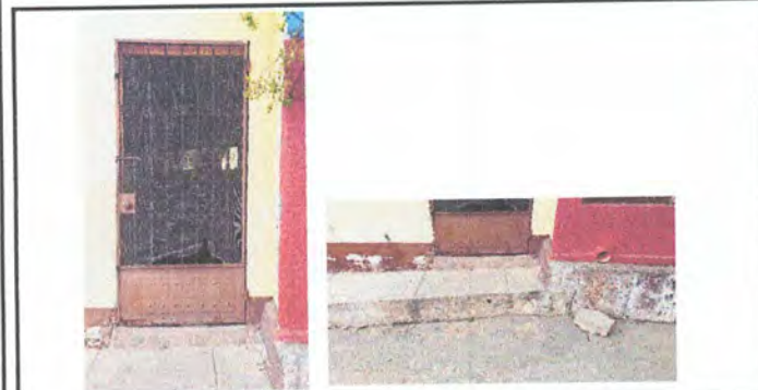
Foto 21: Sustitucion de grada de concreto en area de entrada principal
