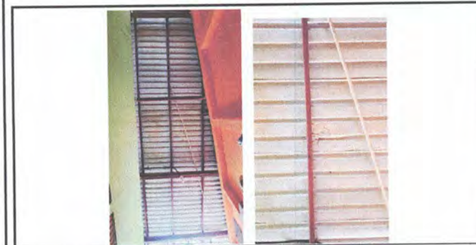
Foto 23: Reparacion de lamina de 3x1 MZ (tapagotera y sellador)
