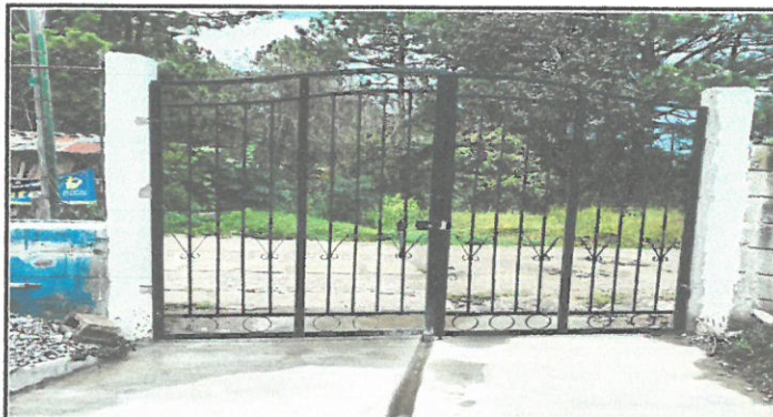
Vista de puerta de entrada principal remozado
