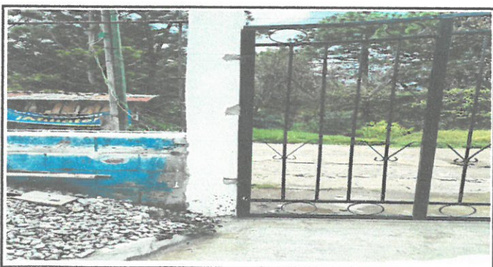
Vista de columnas de concreto remozado
