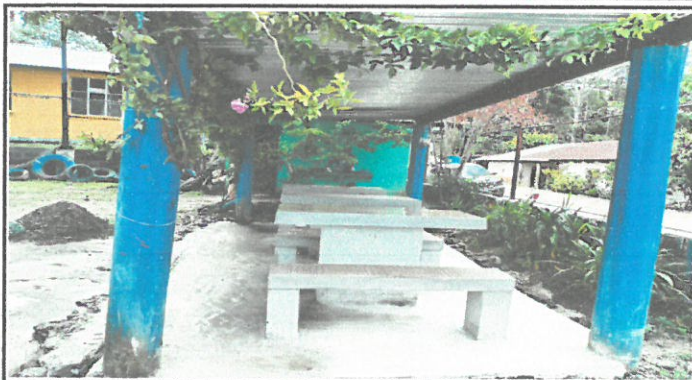
Vista de area de comedor remozado
