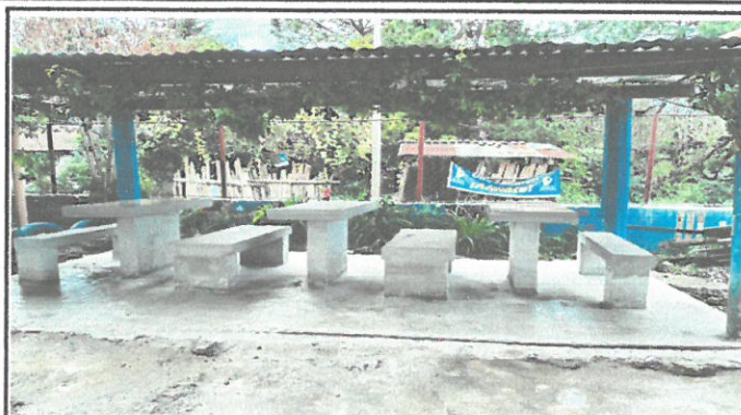
Vista de area de comedor reparado
