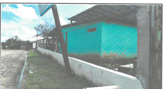
Vista de malla metálica remozado
