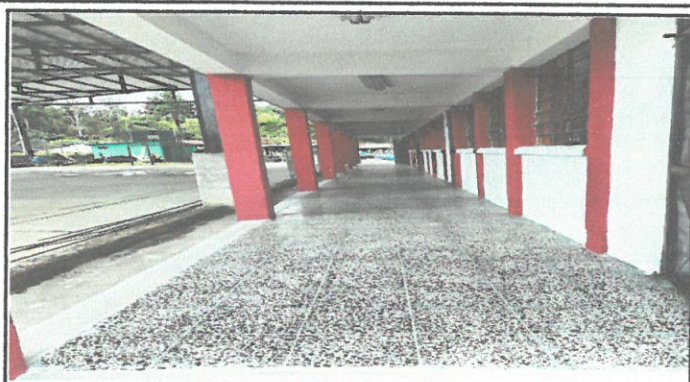
Vista de área de piso de corredores remozado
