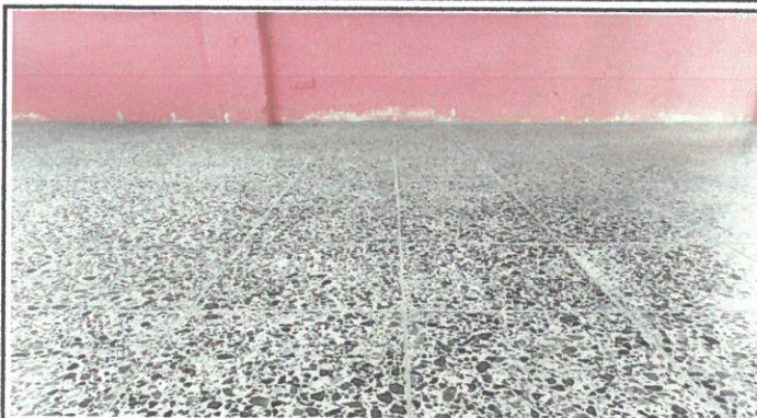
Vista de área de piso de aulas remozado
