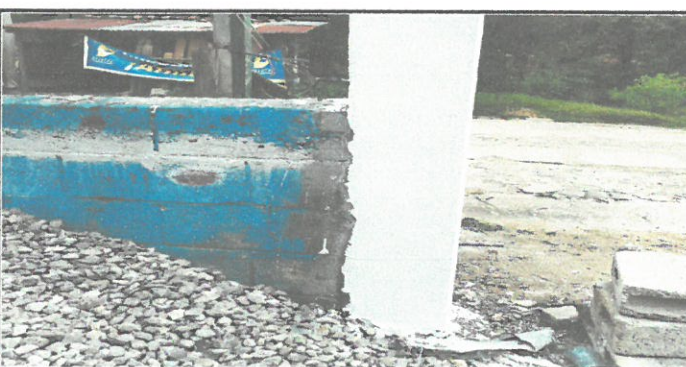
Vista de columnas de concreto en modelo de reparación.
