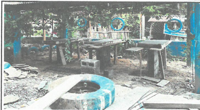
Vista de area de comedor en proceso de remozamiento.
