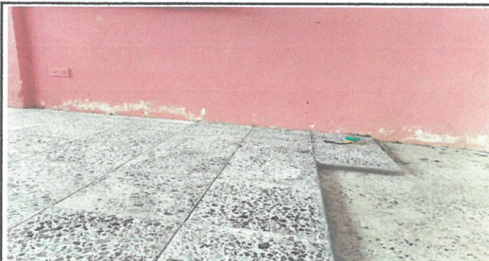
Vista de area de piso de aulas en proceso de remozamiento.
