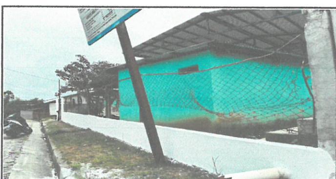
Vista de malla metalica en proceso de remozamiento.
