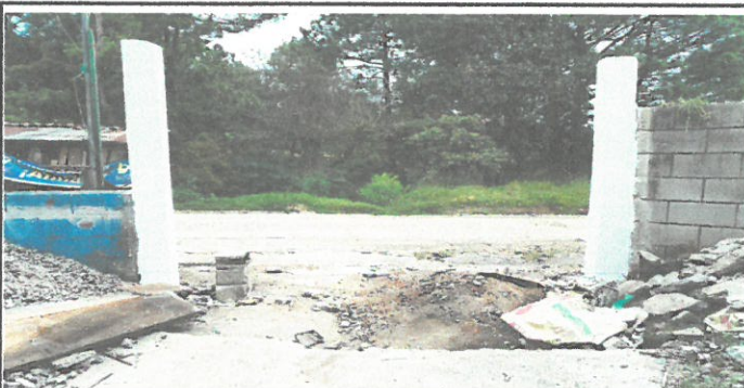
Vista de area de puerta de entrada principal en proceso de remozamiento.
