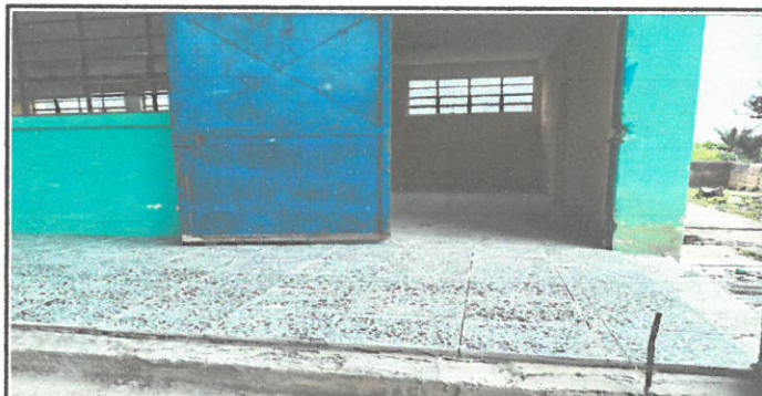
Vista de puertas de aulas en proceso de reparación.
