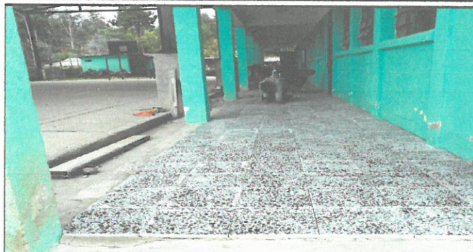
Vista de area de piso de corredores en proceso de remozamiento.
