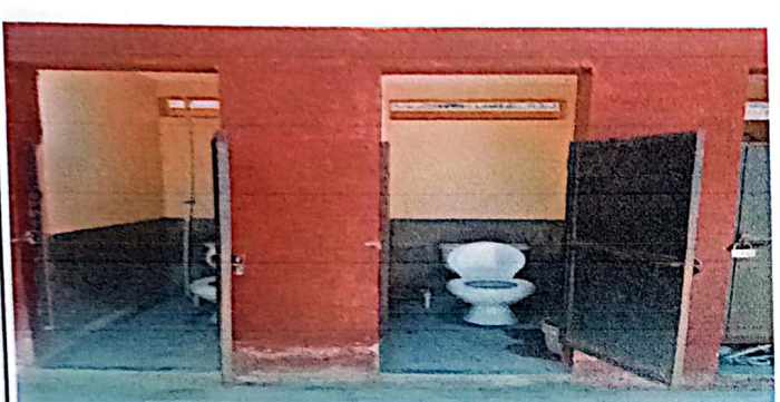
Cambio de Sanitarios
