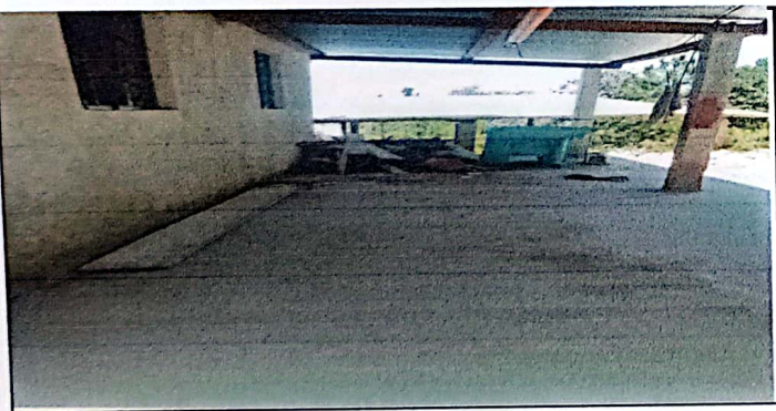
Pavimentacion de corredor de cocina
