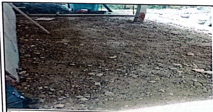
Pavimentacion de corredor de cocina
