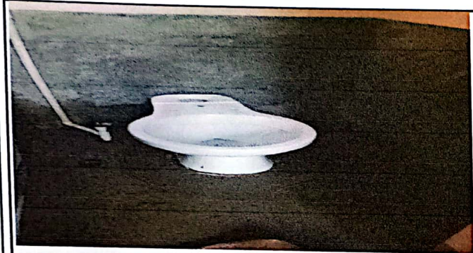
Cambio de Sanitarios
