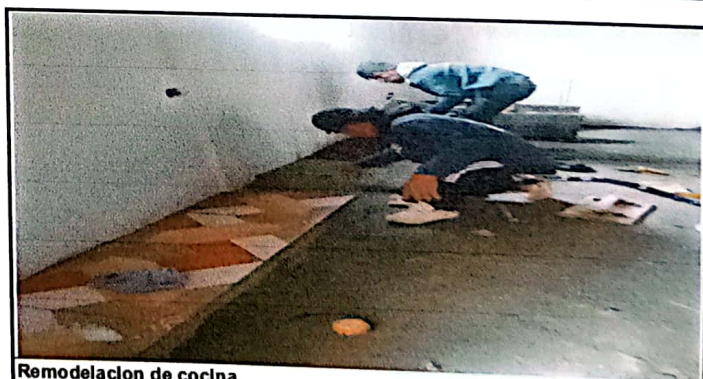
Remodelacion de cocina
