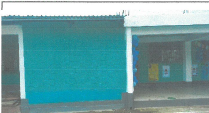
Foto 3: Pintura interior de edificio escolar posterior.
