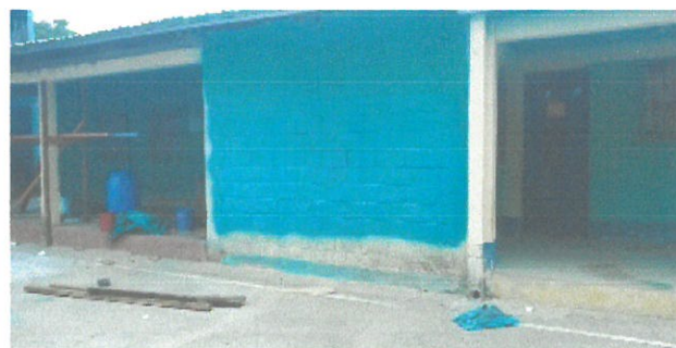
Foto 2: Pintura interior de edificio escolar durante
