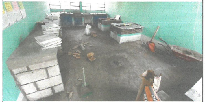
Foto 2: Remozamiento de cocina durante
