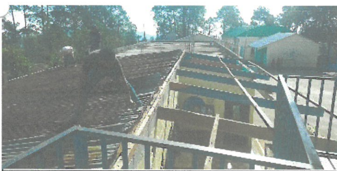
Foto 2: Cambio de techo durante
