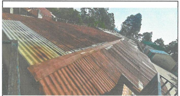
Foto 1: Cambio de techo previo.
