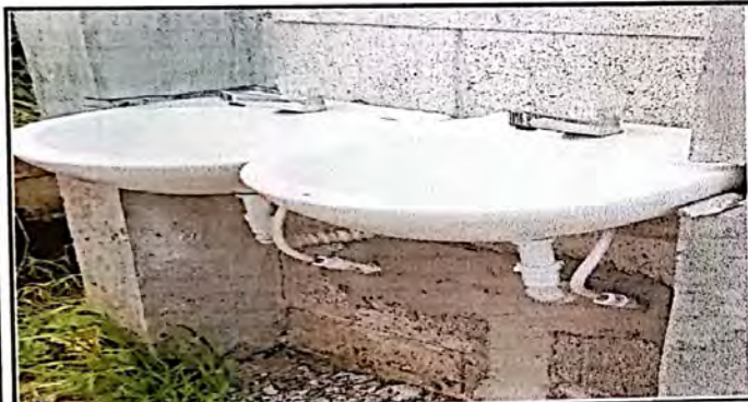
Vista exterior de los baños, que se instalaron los lavamanos
