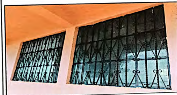
Vista de balcones y rejas que se pinto
