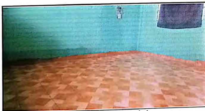
Cambio de piso finalizado de un aula del primer nivel
