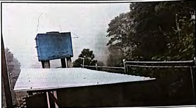
Vista de la cubierta del techo de los baños ya finalizado
