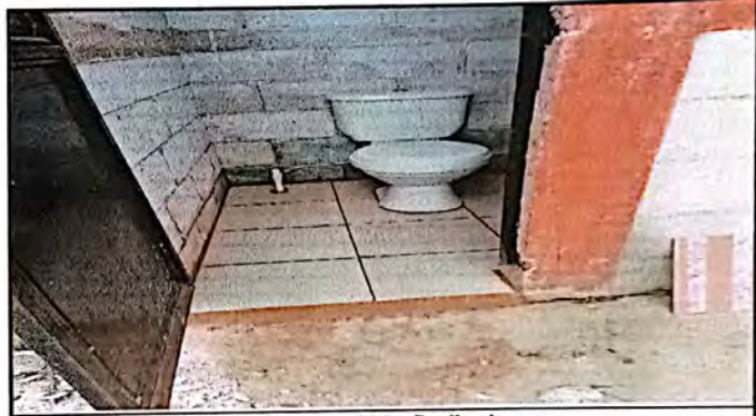
Vista de azulejos instalado en cada baño finalizado
