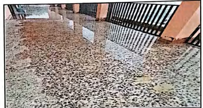
Vista de la perforación de bajada de agua ya finalizado
