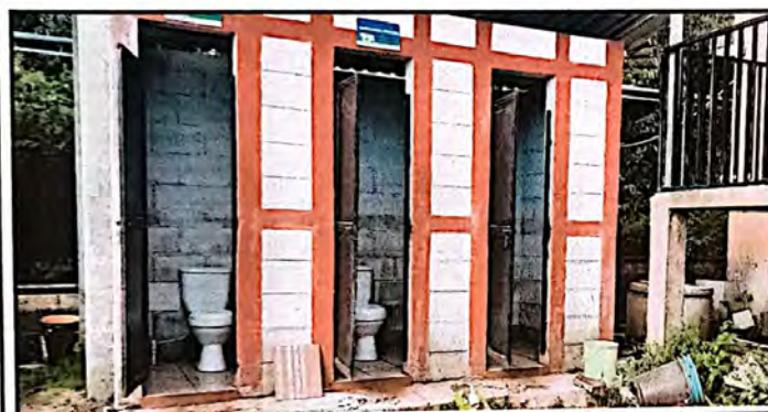
Vista del inodoro de los baños ya finalizado
