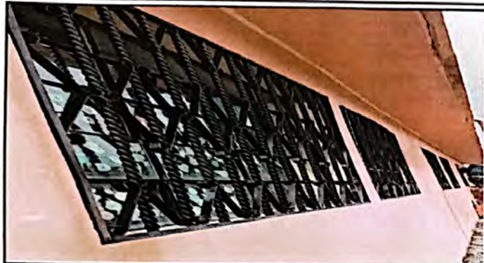
Vista del exterior de las aulas, que se instalaron los balcones
