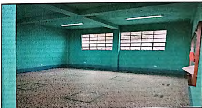
Vista interior de las aulas del segundo nivel ya pintado
