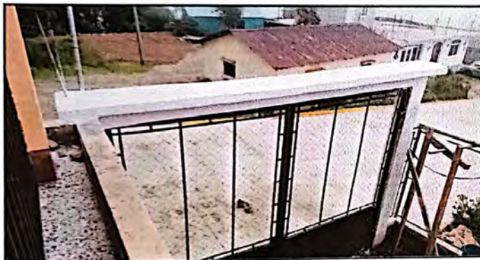
Vista aéreo de la loza finalizada del portón principal
