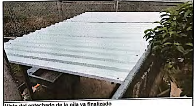
Vista del entechado de la pila ya finalizado
