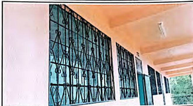
Vista frente el aula, que se instalaron los balcones
