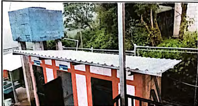
Vista de la cubierta del techo finalizado
