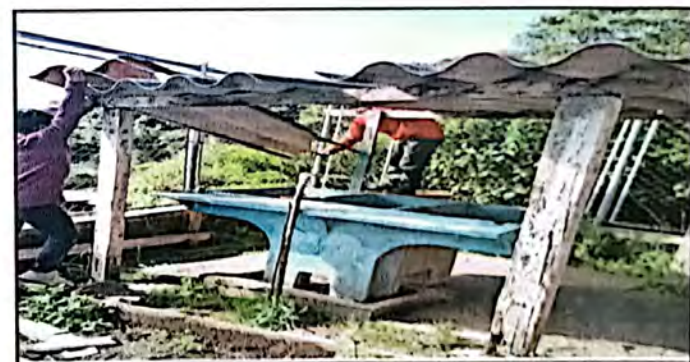
Vista de entechado de la pila que se esta cambiado
