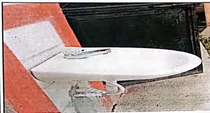
Vista exterior de los baños durante la instalación de lavamanos
