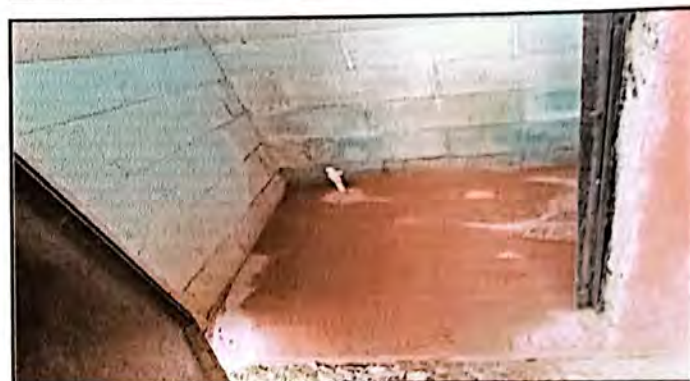
Vista del piso de los baños que se esta aplicando el pegamix para la instalacion de azulejos
