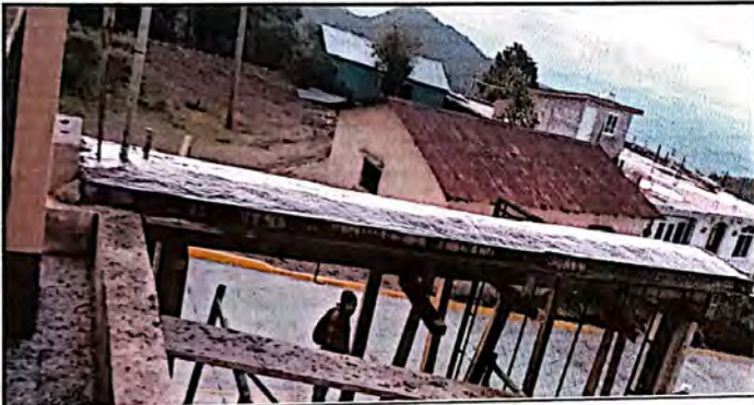
Vista aéreo del portón principal fundiendo la losa
