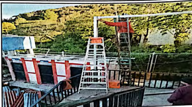
Vista del trabajo del entechado de las gradas.
