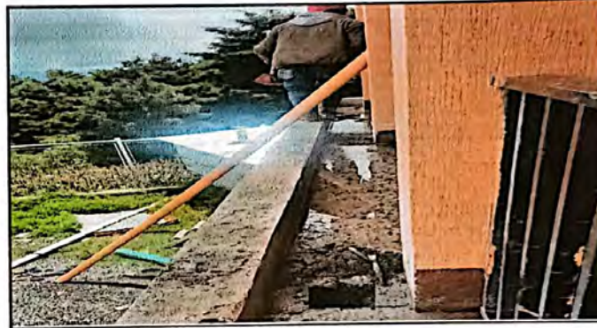
Vista de la perforación de bajada de agua
