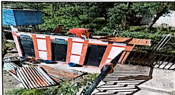
Vista del cambio del entechado de los baños
