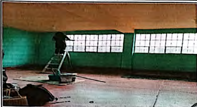
Vista interior de las aulas del primer nivel durante la pintada
