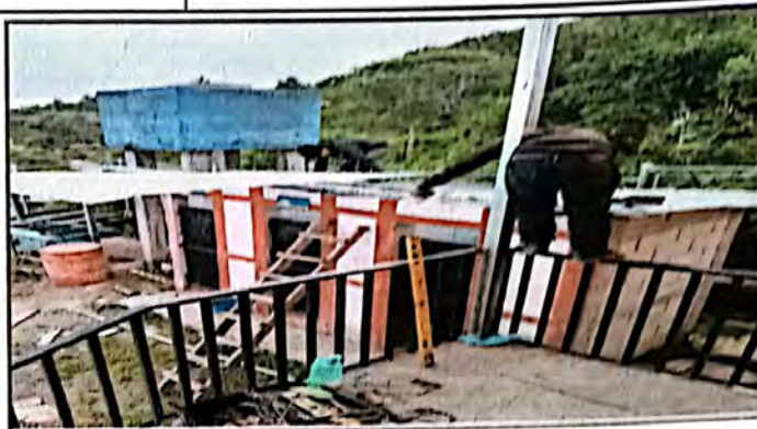
Vista de la instalacion del techo que se esta remozando
