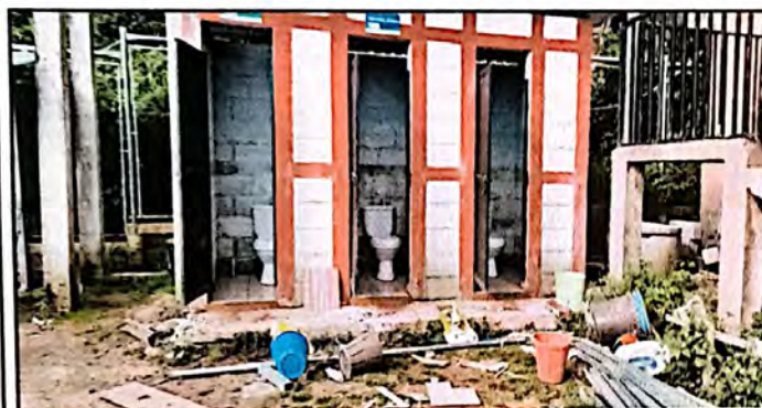
Vista del inodoro de los baños que se esta cambiando
