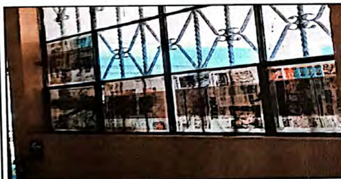
Vista de los balcones y rejas que se esta pintando
