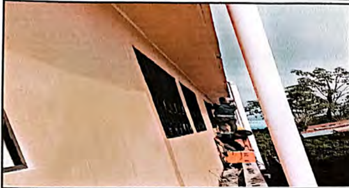
Vista del exterior de las aulas, en la instalación de balcones
