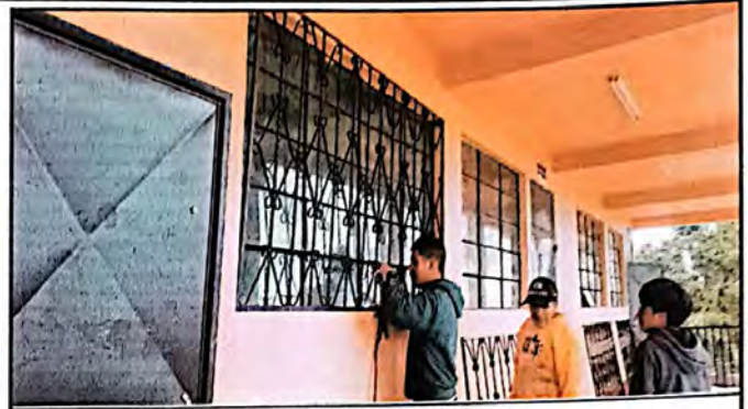
Vista frente el aula durante la instalación de balcones
