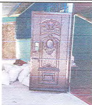
Foto 7: Instalación de puerta al 100% del aula 3.
