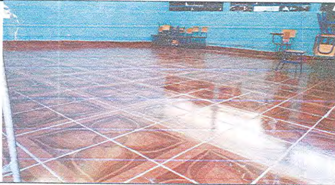
Foto 1: Sustrucción al 100% de piso de cemento por piso de cerámico ilustrado en tres aulas y dirección.
