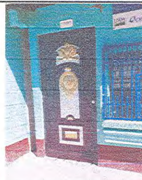
Foto 8: Instalación de puerta al 100% de la cocina.
