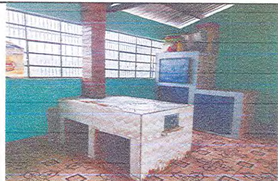
Foto 4: Sustrucción al 100% de pollo o estufa rural de dos ornillos y chimenea de hojalata por chimenea de ladrillo.
