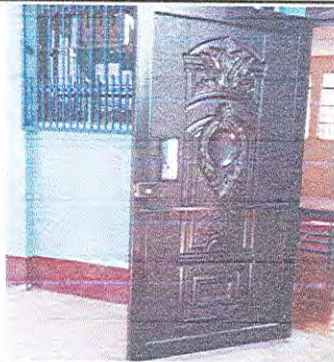
Foto 3: Instalación de puerta al 100% de aula 2.
