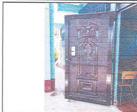
Foto 2: Instalación de puertas al 100% de aula 1.
