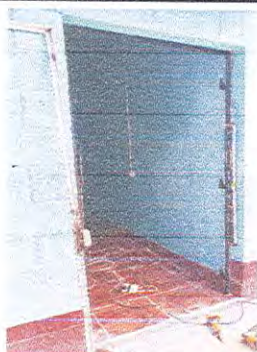
Foto 7: Proceso de instalación de puerta del Aula 3.
