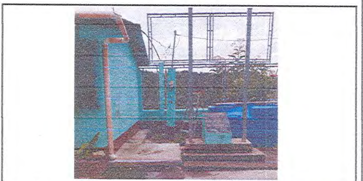
Foto 6: Proceso de instalación de estructura metálica por portante para techo en área de pila.
