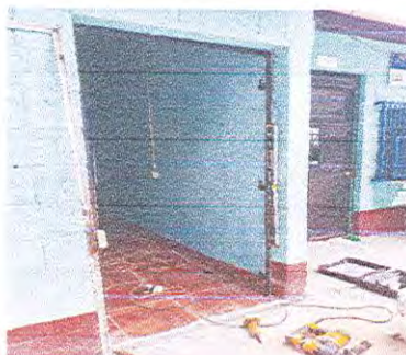
Foto 9: Proceso de instalación de puerta de la dirección.
