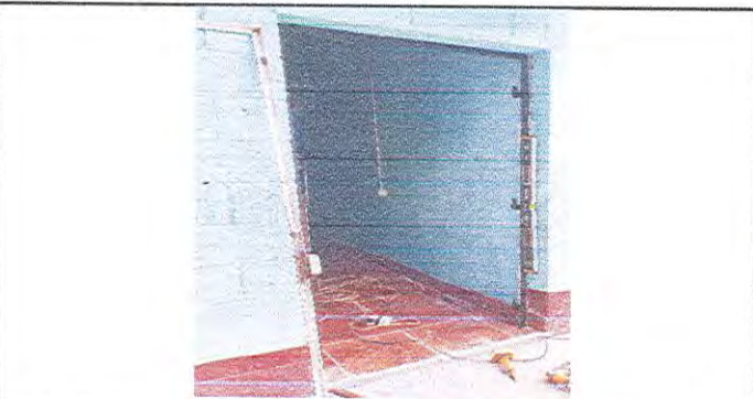
Foto 3: Proceso de instalación de puerta Aula 2.
