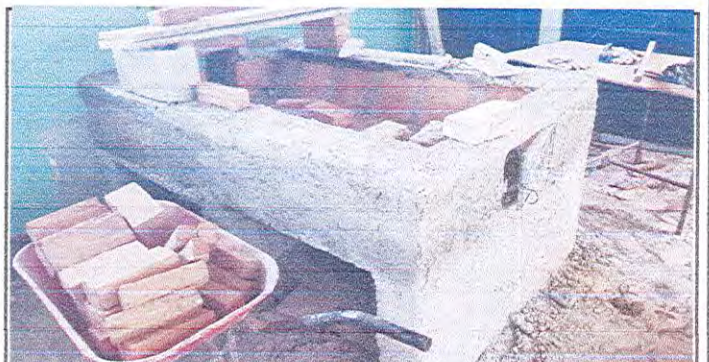
Foto 4: Proceso de Sustitución de pollo o estufa rural de dos ornillas, chimenea de hojalata por chimenea de ladrillo.
