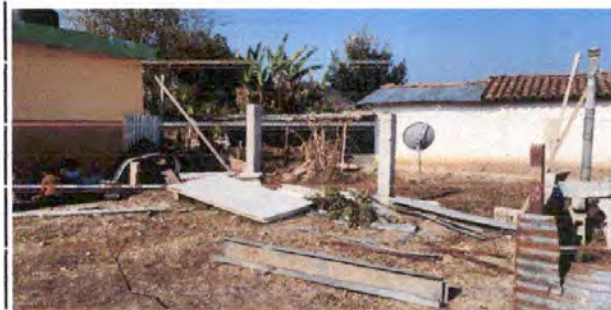
Foto 4: Vista del muro perimetral existente.
