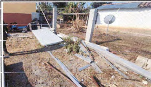
Foto 2: muro perimetral existente, se colocaran hiladas de block, tubo y malla.
