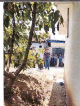
Foto 8: lugar donde se colara un muro de protección para el modulo 2.
