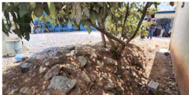
Foto 7: lugar donde se colara un muro de protección para el modulo 2.
