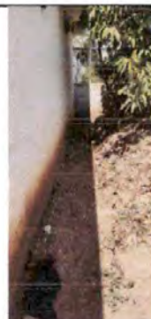
Foto 10: Lugar donde se colara un muro de protección para el modulo 2.
