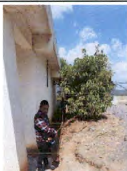
Foto 9: lugar donde se colara un muro de protección para el modulo 2.
