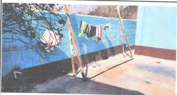
Foto 9: Vista del área donde se colocará un lavamanos de concreto.
