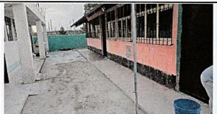
Foto 5: Mejoramiento de pavimentacion de patio.
