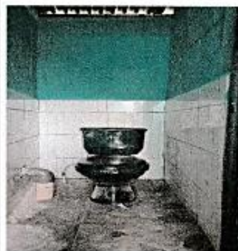
Foto1: Mejoramiento de servicios sanitarios
