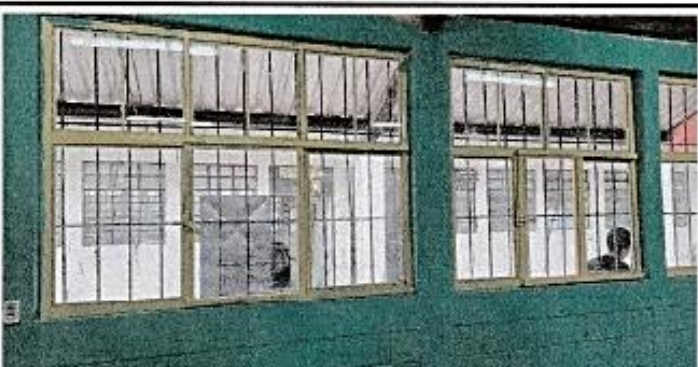
Foto 3: Mejoramiento de ventanas, corredizos,
