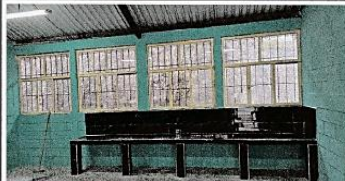
Foto 2: mejoramiento de cocina, construccion de mesa de concreto
