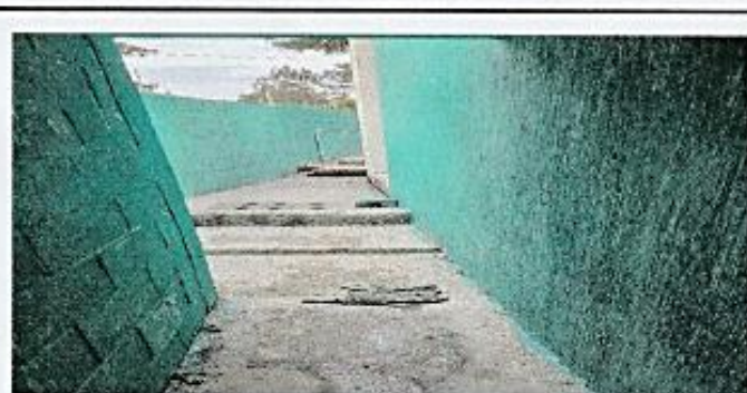
Foto 6: Paredes levantado de block de los baños
