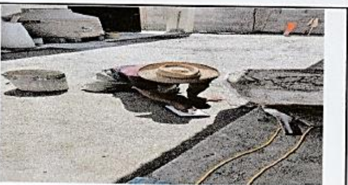
Foto 5: Mejoramiento de pavimentacion de patio.
