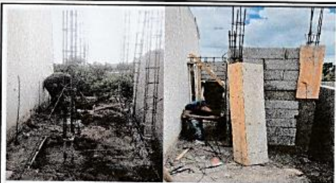
Foto1: Mejoramiento de servicios sanitarios
