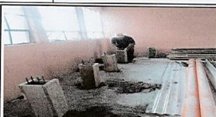
Foto 2: mejoramiento de cocina, construccion de mesa de concreto
