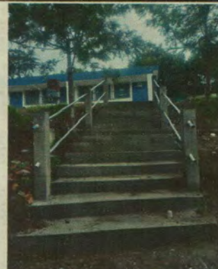
Foto 4: Vista de la realización de gradas con pasamano donde pasan los niños para bajar al campo.
