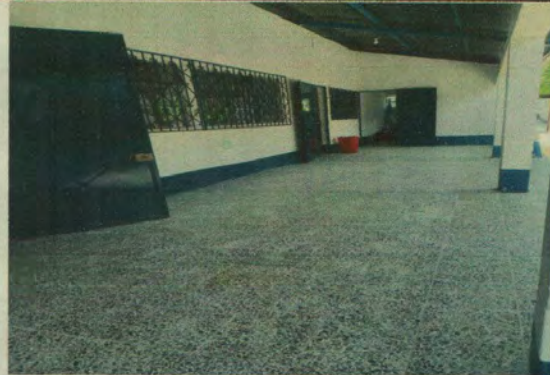
Foto 2: vista de corredor con piso granito puesto y puertas, balcones pintadas.
