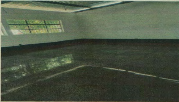
Foto1: Vista de una de las aulas con piso granito puesto
