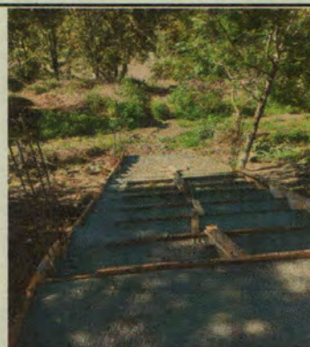
Foto 4: Proceso de pavimentación con gradas y pasamanos del camino para bajar al campo.
