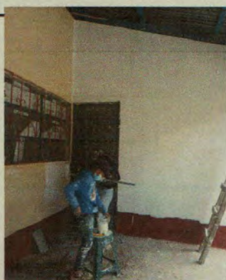
Vista del proceso de pintada de pared exterior de las aulas de láminas con color blanco y zócalo será pintada de azul.
