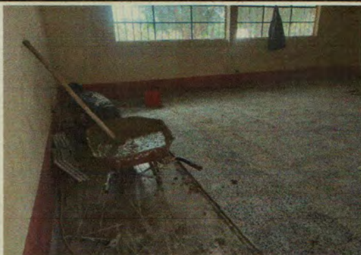
Foto1: Vista de una de las aulas en proceso de colocación de piso granito
