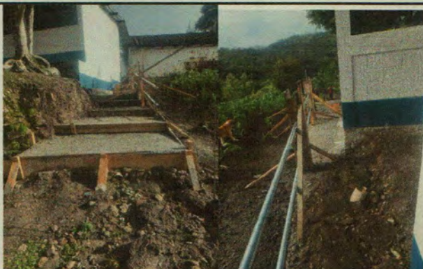
Foto 3: Vista del proceso de pavimentación con gradas y pasamanos del caminito de los niños al recibir su alimentación o bajar al campo.
