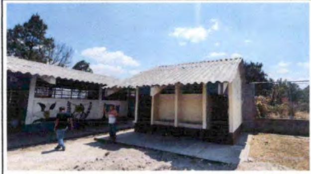
Foto 8: Vista frontal de los baños.
