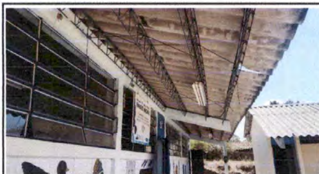
Foto 5: Vista del pasillo del modulo 2, lamina existente de fibrocemento, se encuentra en mal estado.
