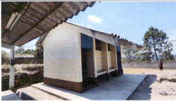
Foto 7: Vista lateral de los baños.
