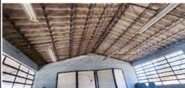
Foto 4: Vista interior de modulo 2, lamina existente de fibrocemento, se encuentra en mal estado.
