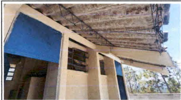
Foto 10: Vista de estructura portante y cubierta de lamina están en mal estado.
