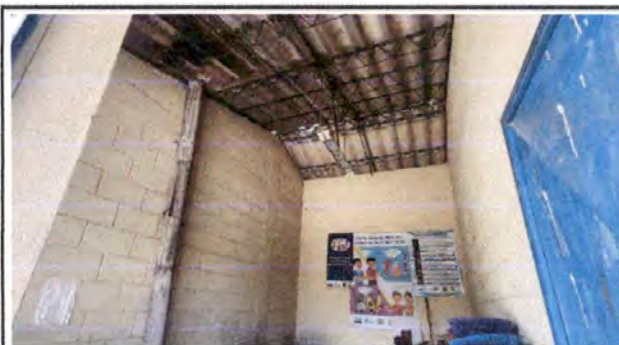
Foto 6: Vista interior de modulo 2 en área de cocina, lamina existente de fibrocemento, se encuentra en mal estado.
