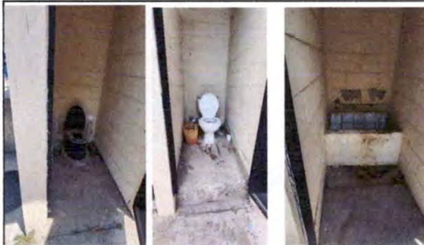
Foto 10: vista del interior de los baños, se cambiarán inodoros, se colocara nueva tubería de drenaje.
