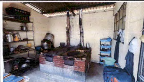
Foto 8: Vista interior de la cocina, se observa la estufa mejorada la cual se remozará, cambiando ladrillos y tubería de la chimenea.
