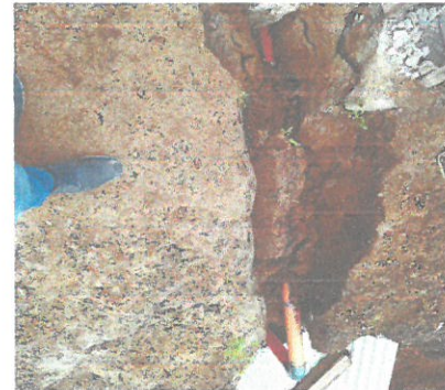
Foto 4: Instalacion de tuberia de drenaje
