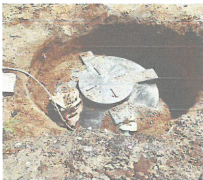
Foto 5: Instalacion de biodigestor
