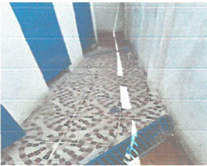
Foto 3: Fondo y pasillo de los baños
