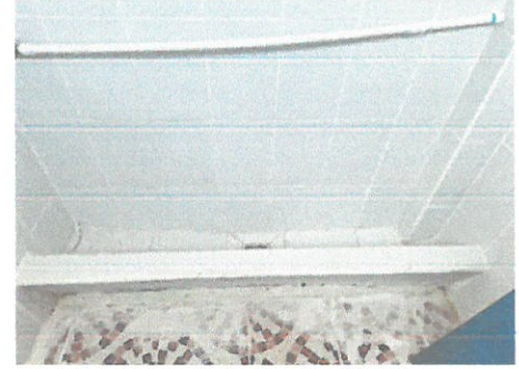
Foto 2: Techo y parte superior de los baños.
