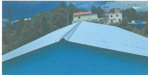
Cambio Total por goteo en aulas de quinto A, primero B, por nuevas troqueladas calibre 26
