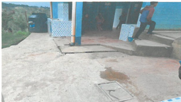
Reparación de depósito y pavimento destruido
