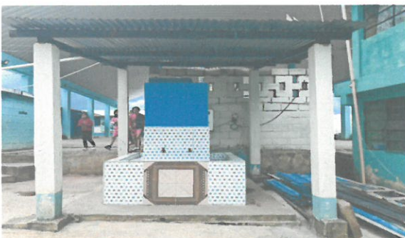
Colocación de cerámica y arreglo total de lavamanos
