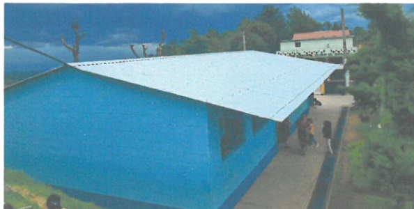
Cambio Total de laminas por goteo aula primero A, segundo B, por nuevas troqueladas calibre 26.
