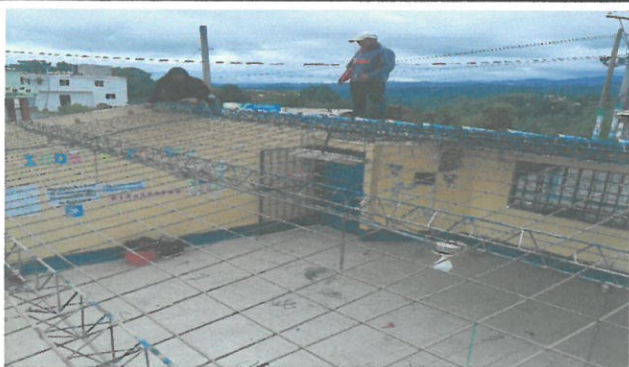
Cambio Total de laminas por goteo aula primero A, segundo B, por nuevas troqueladas calibre 26.
