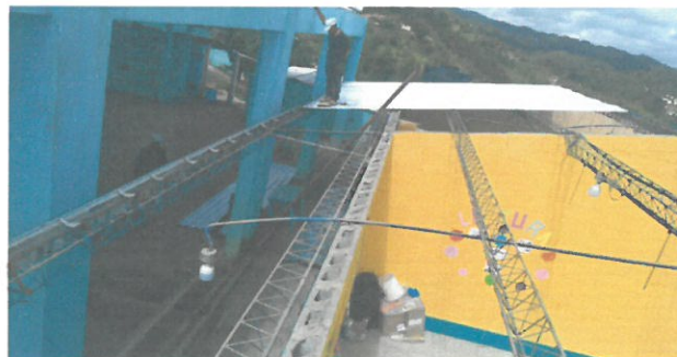
Cambio Total por goteo en aulas de quinto A, primero B, por nuevas troqueladas calibre 26
