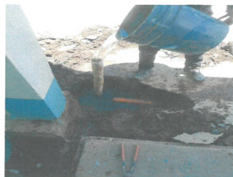
Colocacion de tubos para drenaje y salida del agua hacia la red de drenaje.
