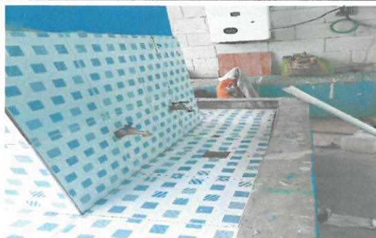
Colocación de cerámica y arreglo total de lavamanos
