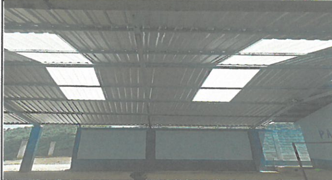
Foto 1: Culminacion del trabajo con lo que respecta el entechado de pasillo
