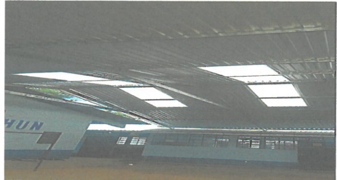
Foto 2: Se observa detalladamente el trabajo efectuado.
