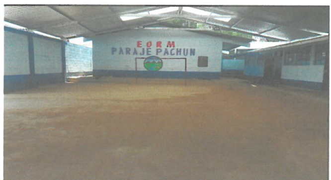
Foto 4: Culminacion de pavimento del patio del establecimiento educativo lugar donde se efectua las distintas actividades.
