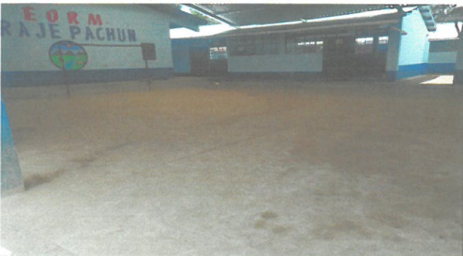
Foto 3: Pavimentacion de un lado del patio.
