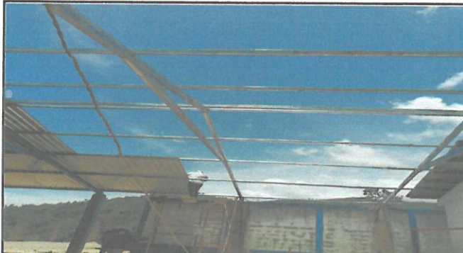
Foto 1 : Se esta colocando la estructura de metal del pasillo de la escuela.
