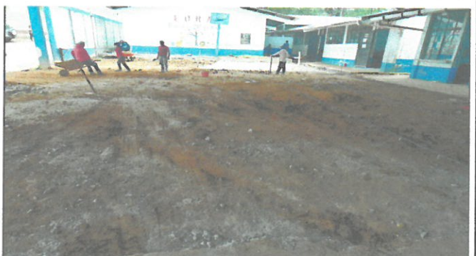
Foto 4: Se esta trabajando para la pavimentacion del 85% por ciento del patio de la escuela.
