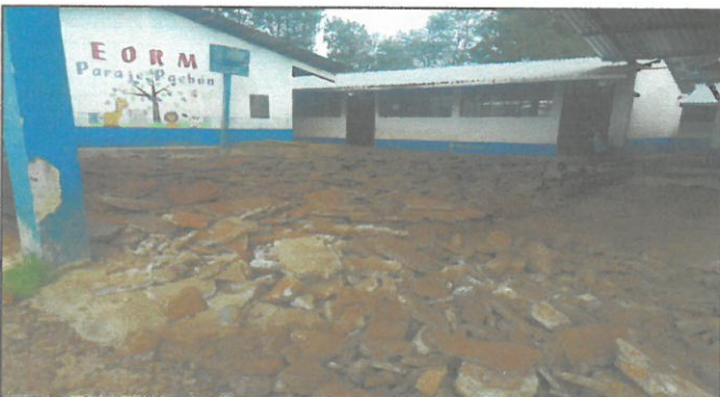
Foto 3: Se efectuo la destruccion del piso del patio para el arreglo de la misma.
