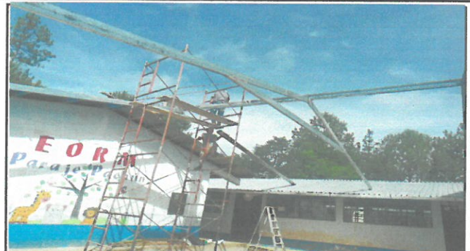
Foto 2: Se esta progresando detenidamente la colocacion del entechado de pasillo.
