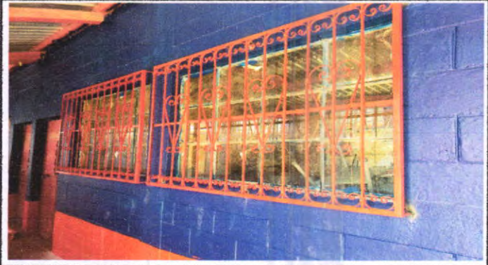
SE OBSERVA LOS BALCONES YA INSTALADAS Y NUEVAS
