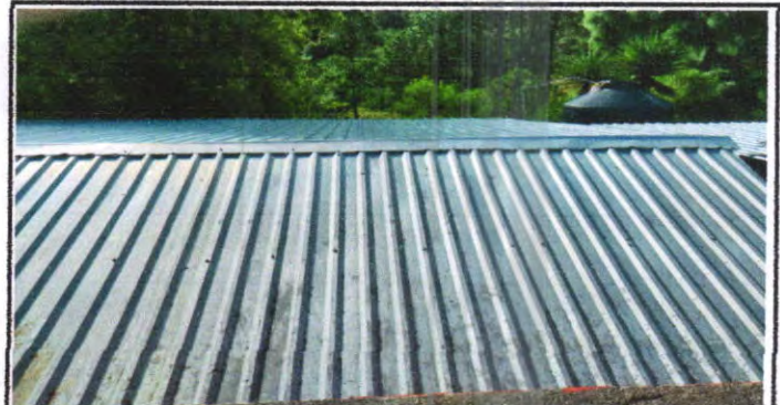
SE OBSERVA LA SUSTITUCION CUBIERTO DE TECHO DE LAS DOS AULAS
