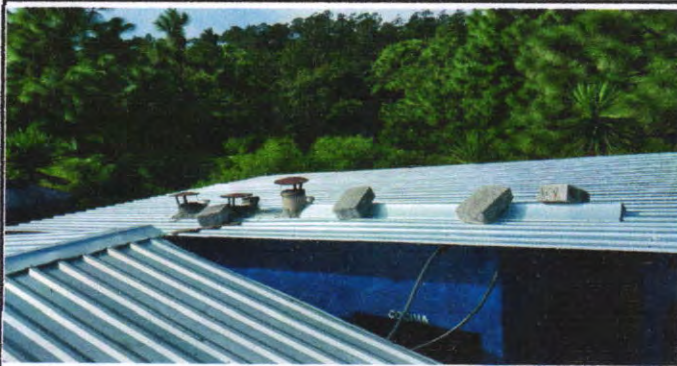
SE OBSERVA LA SUSTITUCION DE CUBIERTO DE TECHO DE LA COCINA
