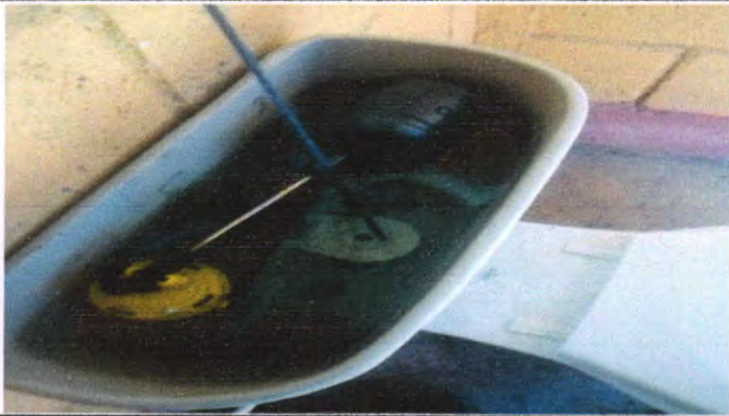
SE OBSERVA LOS ACCESORIOS DE LOS SERVICIOS SANITARIOS YA INSTALADAS
