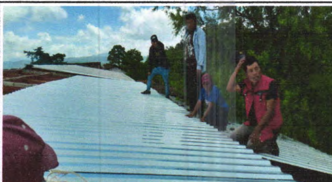
SE OBSERVA LA SUSTITUCION CUBIERTO DE TECHO DE LAS DOS AULAS
