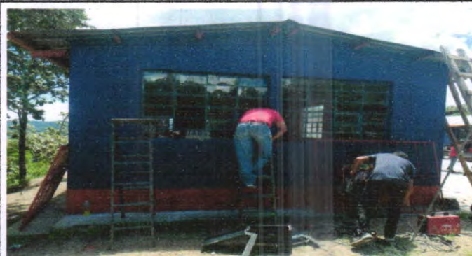
SE OBSERVA LA COLOCACION DE LOS BALCONES DE LAS AULAS
