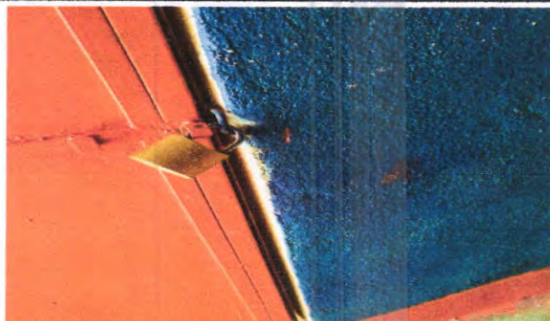
Sustitución de candados de los servicios sanitarios
