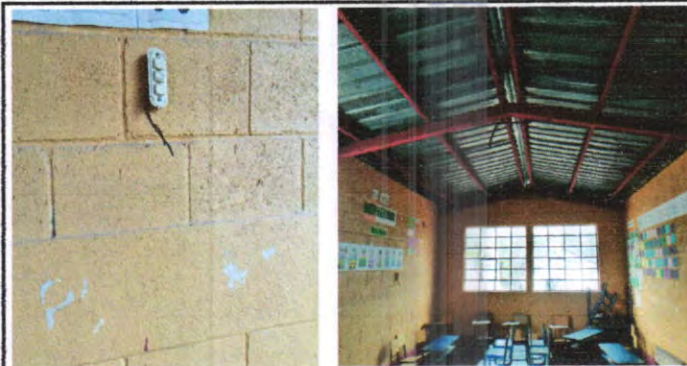
SE OBSERVA LA INSTALACION DE LA ELECTRICIDAD EN DOS AULAS
