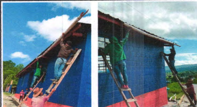
SE OBSERVA EL CAMBIO DE TUBOS PARA LOS CANALES DE AGUA
