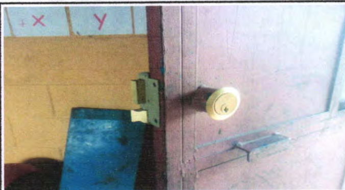
SE OBSERVA LA SUSITITUCION DE LAS CHAPAS
