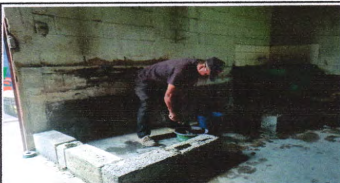
SE OBSERVA EL TRABAJO DE REMODELACION DE LAS PLANCHAS
