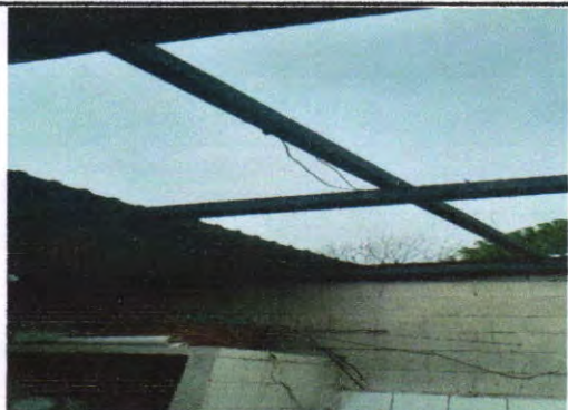
SE OBSERVA LA SUSTITUCION DE CUBIERTO DE TECHO DE LA COCINA
