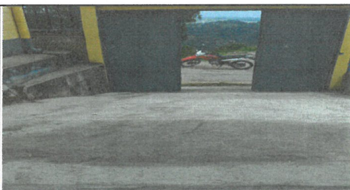
Sustitución de las gradas por rampa de concreto en su fase final
