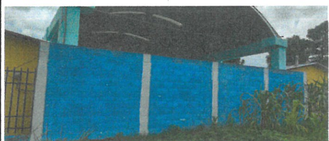
Levantamiento de block fase final del muro parte exterior
