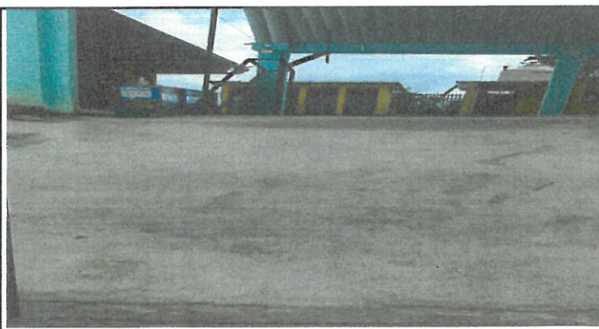
Cambio de las gradas por rampa de concreto en su fase final
