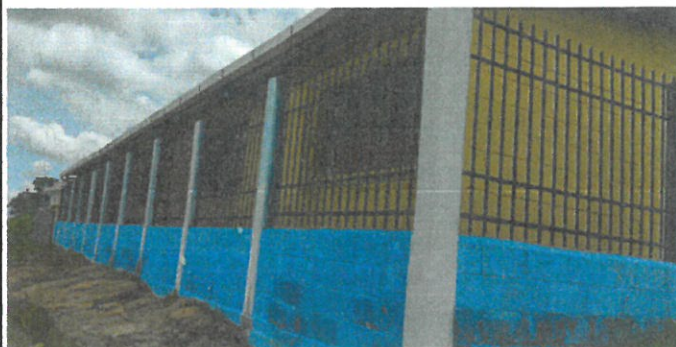
Sustitucion de maya perimetral por baranda de metal
