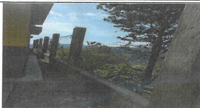
sustitucion e maya perimetral, por baranda de metal
