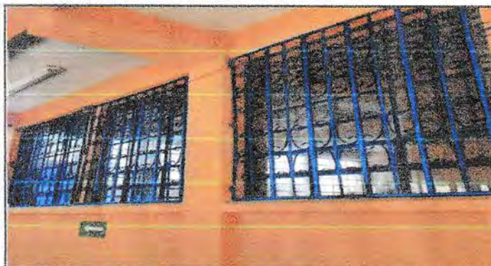
Foto 3: Instalación completa de balcones del aula de tercero primaria y dirección
