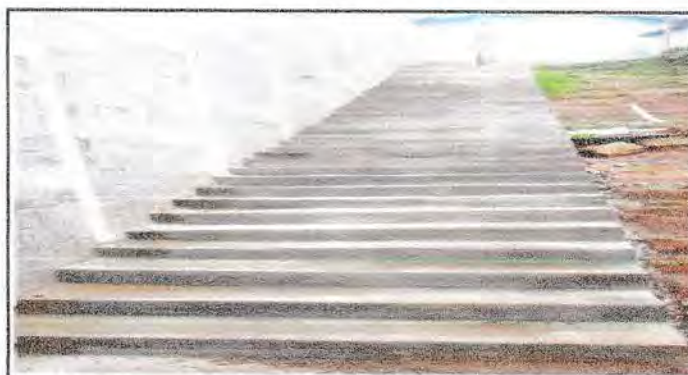
Foto 4: Gradas para acceso a aulas de los grados de cuarto, quinto y sexto primaria.
