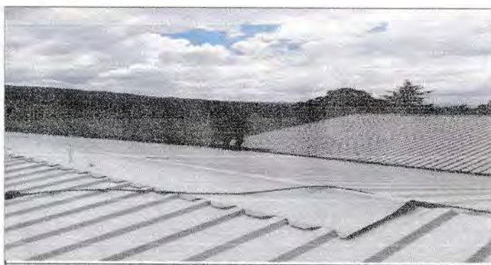
Foto 5: Techo con lamina troquelada del nivel preprimario
