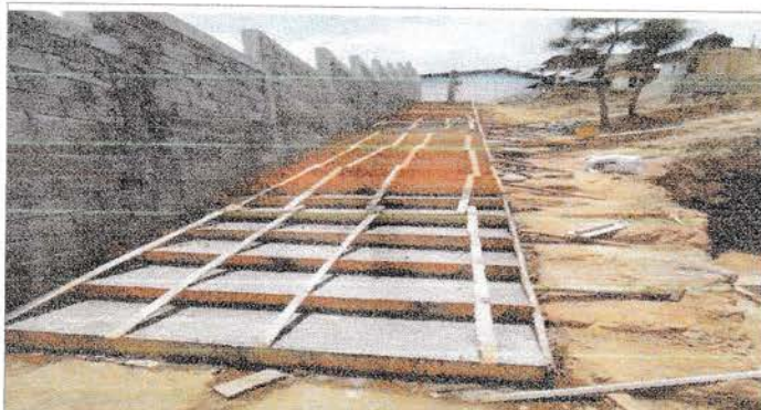
Foto 3: Fundición de gradas de concreto de 3 pulgadas de espesor
