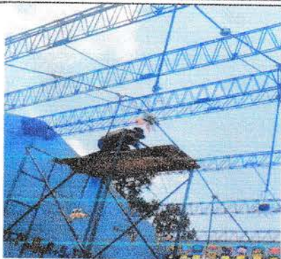
Foto 1: Sustrucción de techo de fibrocemento con lámina troquelada.
