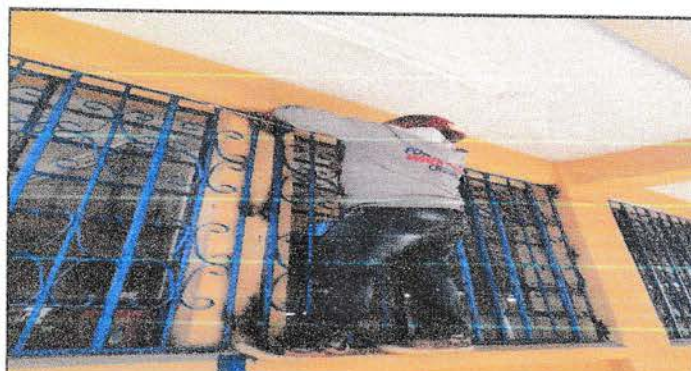
Foto 4: Colocación de balcones en aulas de tercero primaria y dirección
