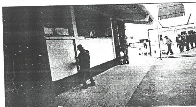
Foto 6: Vista exterior de las aulas que se pintarán
