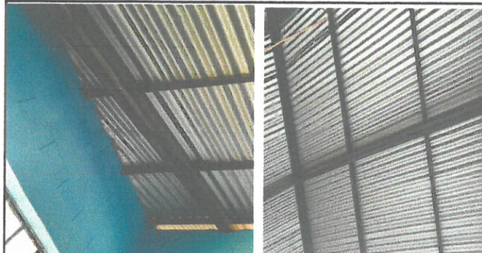
Impermeabilización de techo de dos aulas
