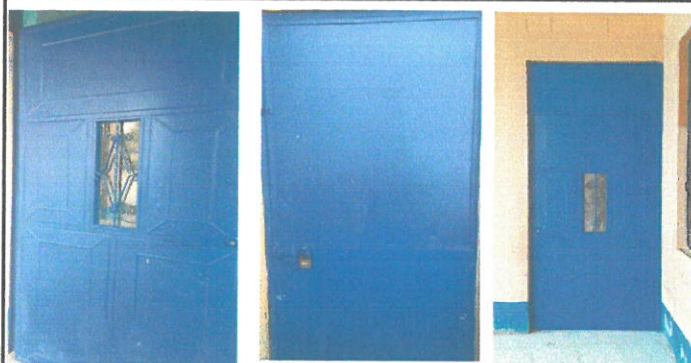
Mantenimiento de puertas
