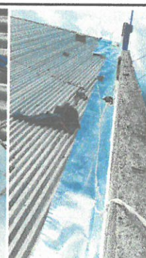
Impermeabilizacion y cambio de laminas de techo de dos aulas y cambio de laminas en el area de cocina.
