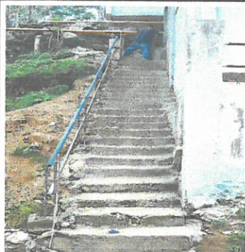
Colocación de dos barandas de cemento y de tubo de metal, uno en el lado derecho y otro en el lado izquierdo.
