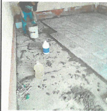
Sustitucion de piso de cemento por piso de granito, para dos aulas, corredor y area de cocina.
