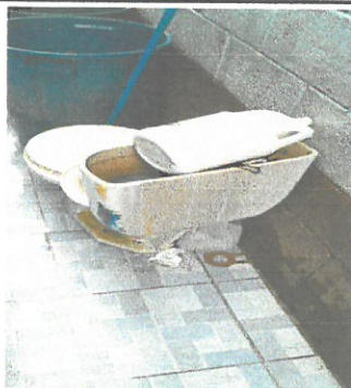
Cambio de dos tazas quebradas para sanitario de color blanco y remplazar por nuevo.
