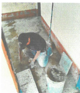
Sustitucion de piso de cemento por piso de granito, para dos aulas, corredor y area de cocina.
