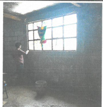
Realización de repello de aula con monocapa.
