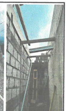
Impermeabilizacion y cambio de laminas de techo de dos aulas y cambio de laminas en el area de cocina.
