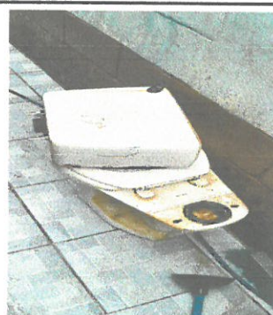
Cambio de dos tazas quebradas para sanitario de color blanco y remplazar por nuevo.
