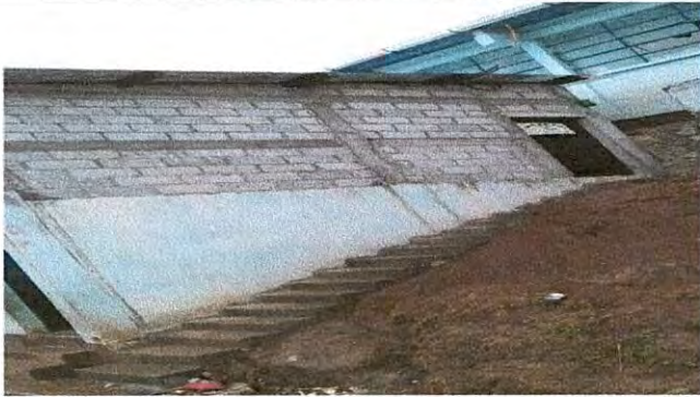
Colocación de dos barandas de cemento y de tubo de metal, uno en el lado derecho y otro en el lado izquierdo.
