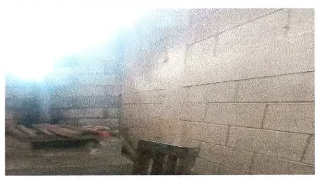
Mantenimiento en cocina de cambio de planchas y poner azulejos.
