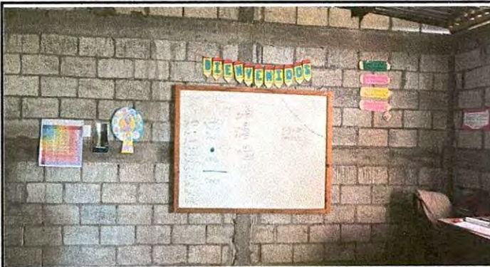
Realización de repello de aula con monocapa.
