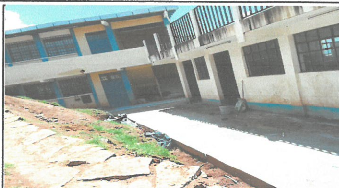
Foto 2: Instalacion de piso ceramico de granito.
