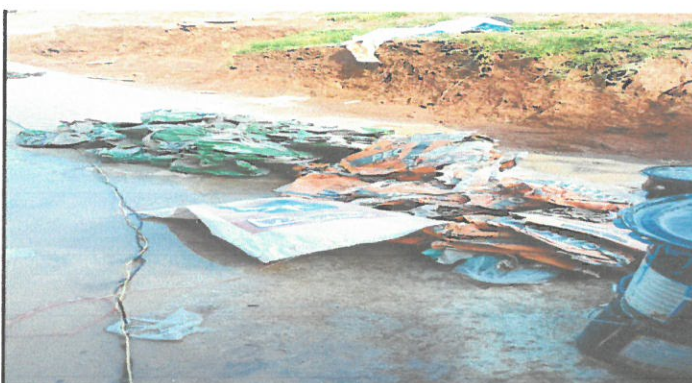
Foto 4: Fundicion de pavimento en frente de las instalaciones.
