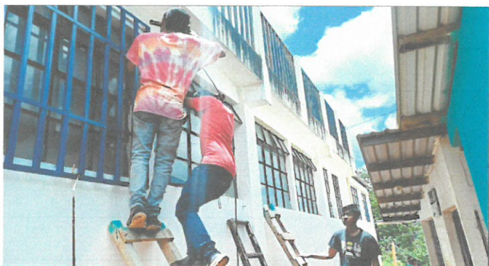
Foto 3: Instalaciones de balcones parte de atrás.
