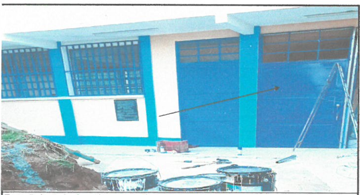
Foto 5: Instalacion de puerta de metal.
