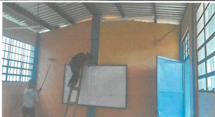
Foto1: Sustitucion de pinturas.
