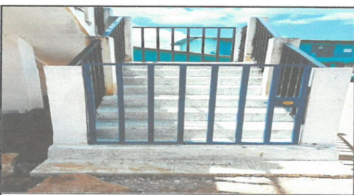
Foto 6: Instalacion de baranda.
