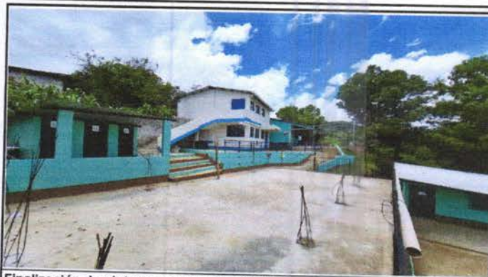
Finalización de pinturas en las aulas interno y externo.
