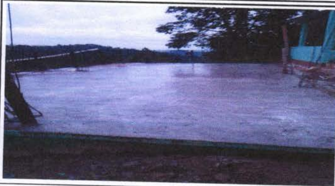
Finalización de reparación de loza en terraza.
