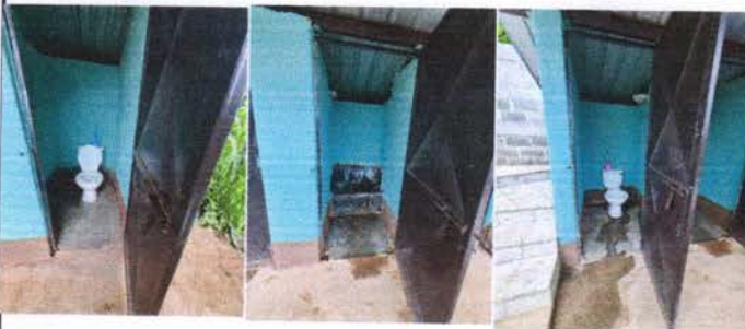
Cambio de inodoro en los dos baños.
