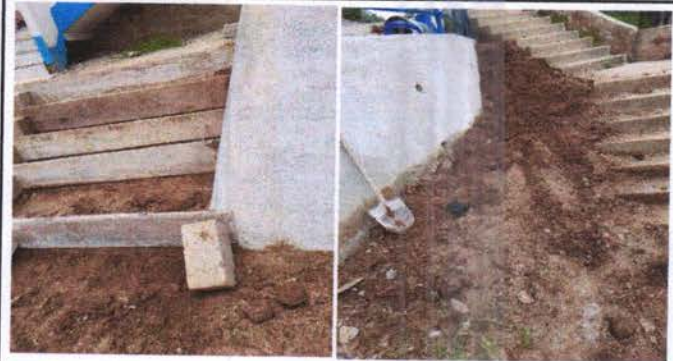
Reparación de loza y gradas.
