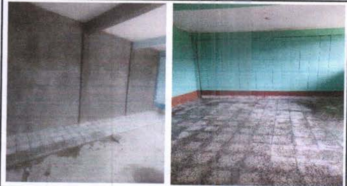
Cambio de piso de torta de cemento por pisos de granitos.
