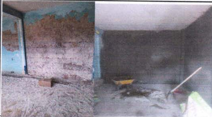
Reparación de pared por humedad
