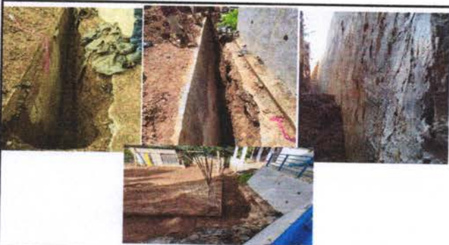
Reparación de pared exterior
