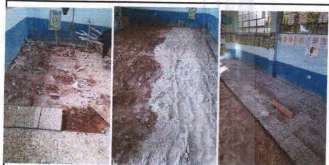
Remodulación de aula.
