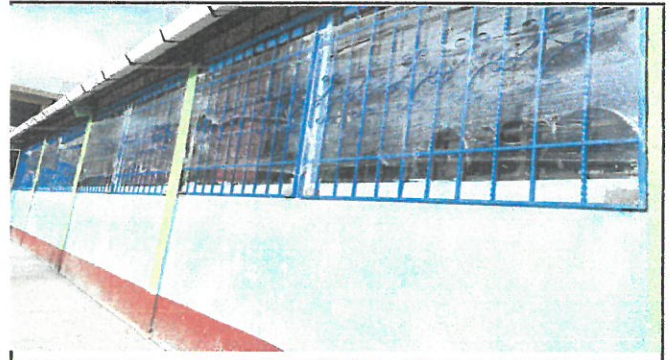
Foto 2: Colocación de Balcones
