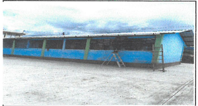
Foto 4: Pavimentación de patio
