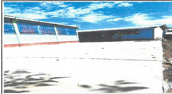
Foto 3: Pavimentación de Patio
