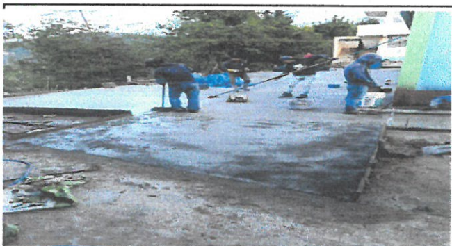
Foto 4: Pavimentación de patio
