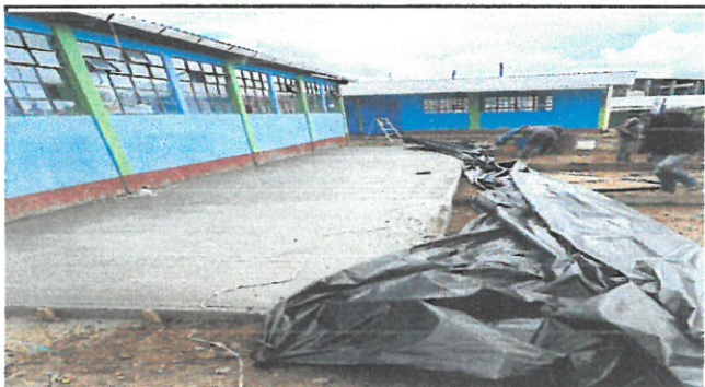
Foto 3: Pavimentación de Patio
