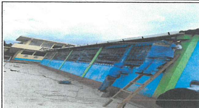
Foto 2: Colocación de Balcones
