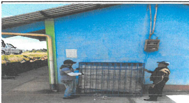
Foto1: Colocación de balcones
